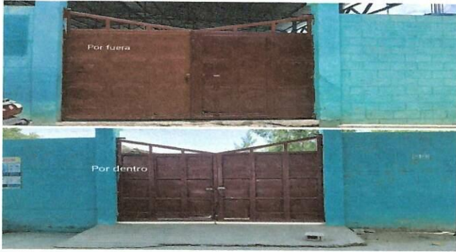
Foto 1: Se realizará cambio del portón por una nueva de la entrada principal del establecimiento.
