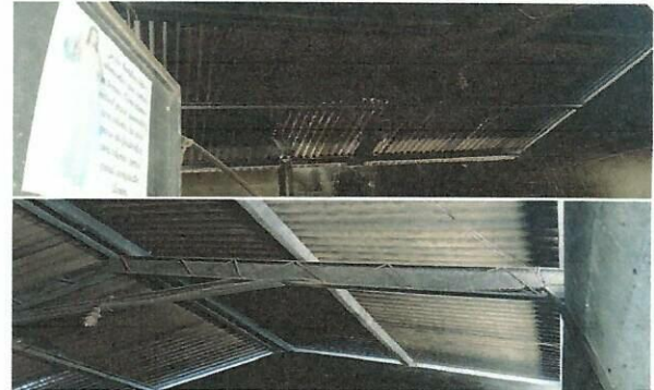
Foto 4: Se hará el cambio de techado a lámina troqueleada de la cocina.
